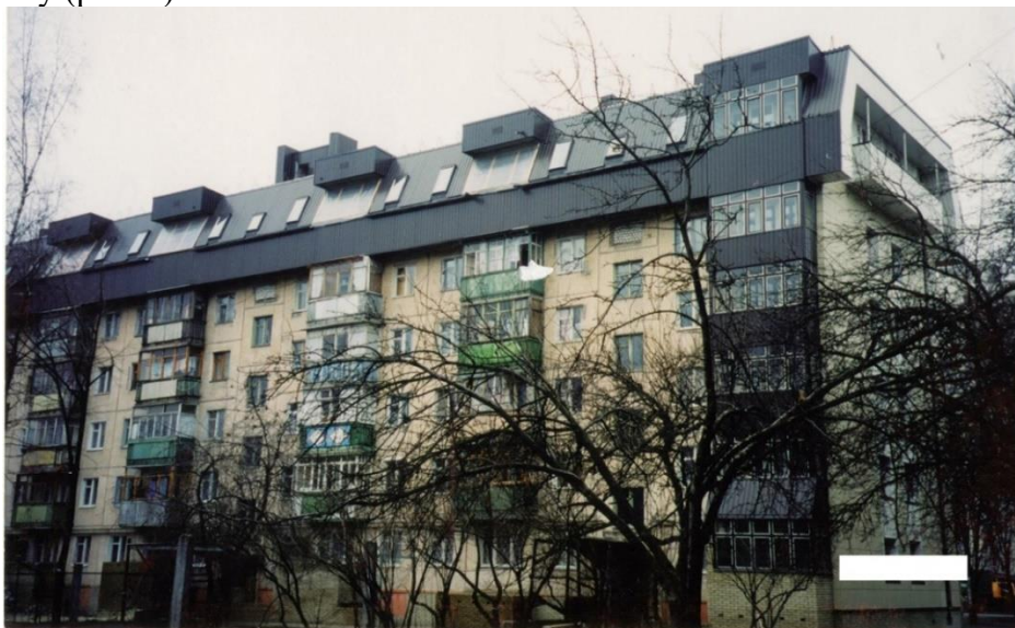
Рис. 2. Загальний вигляд реконструйованого будинку
