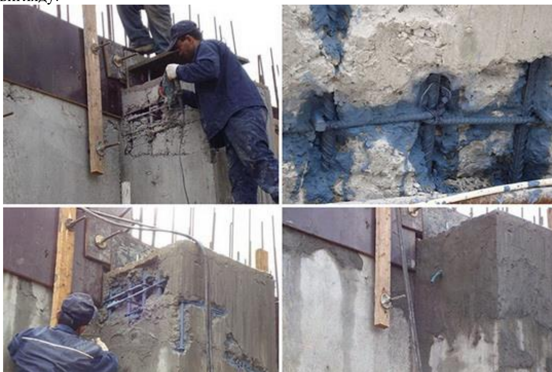
Рис. 2. Патч-ремонт будівельної конструкції [5].
