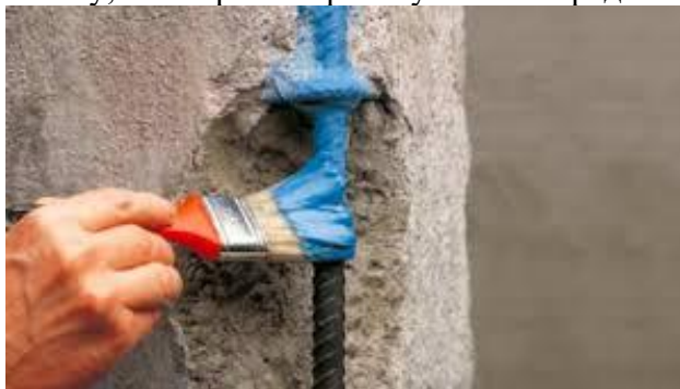
Рис. 3. Нанесення захисних покриттів
