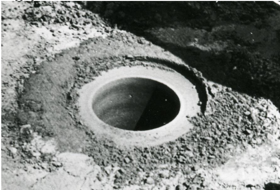
Рис. 4. Трубчасті палі, вироблені за допомогою установки вібровакуумування.
