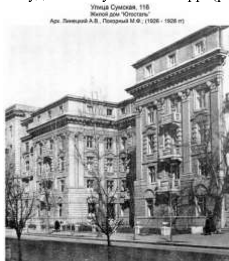
Рис. 4. Будинок №116 по вул. Сумській в м. Харкові. Арх. А. Лінецький, М. Покорний
