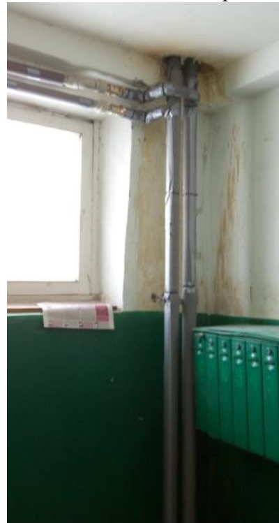
Рис. 2. Фрагменты прокладки новых стояков и ответвлений в квартиры в подъезде
