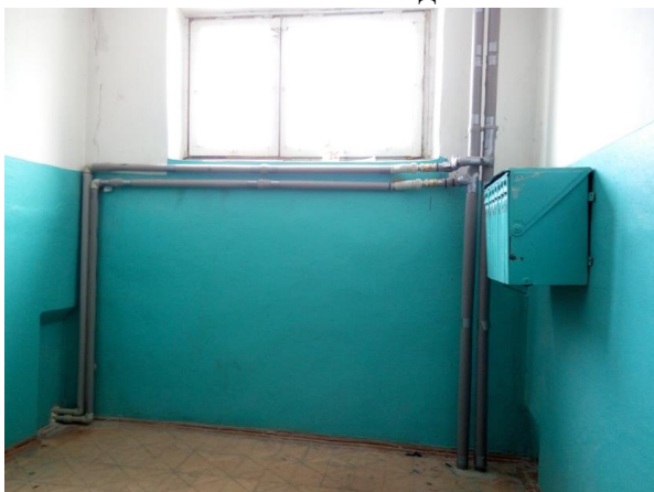
Рис. 1. Фрагмент прокладки новых труб в подъезде
