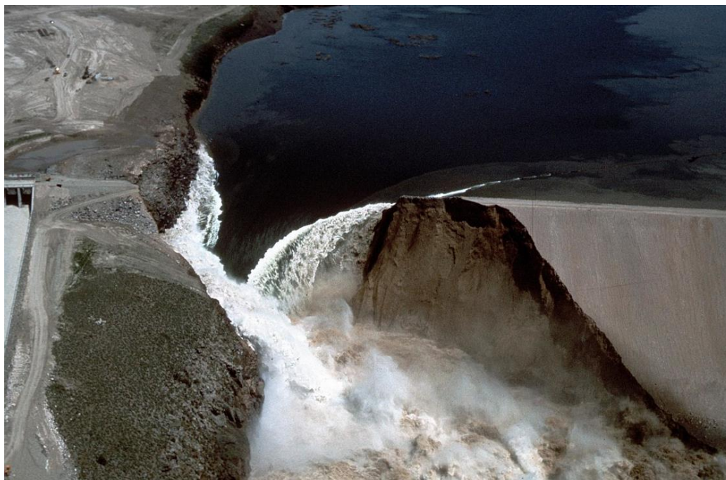
Рис. 1. Прорив греблі Тетон в Рексбурзі, штат Айдахо, США
