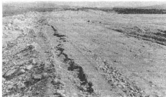
Рис. 5. Формування оповзання на схилі греблі. Первинна тріщина відриву
