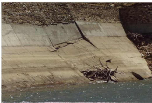
Рис. 3. Руйнування греблі Апішана, США, травень 1987 року
