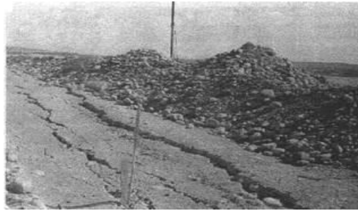
Рис. 4. Тріщини з вертикальним уступом по кордоні ядра з бічної призмою
