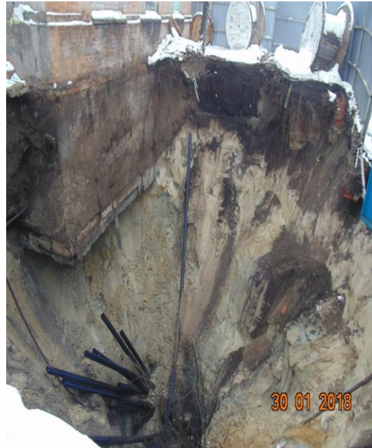
Рис. 1. Аварійне пошкодження каналізаційного тунелю по вул. Греківській (м. Харків, Україна 2017 р): а - конструктивне рішення камери гасіння; б - наслідки аварії; 1 - примикання каналізаційного колектора до камери гасіння; 2 - каналізаційний тунель аروحного типу; 3 - місце обвалення
