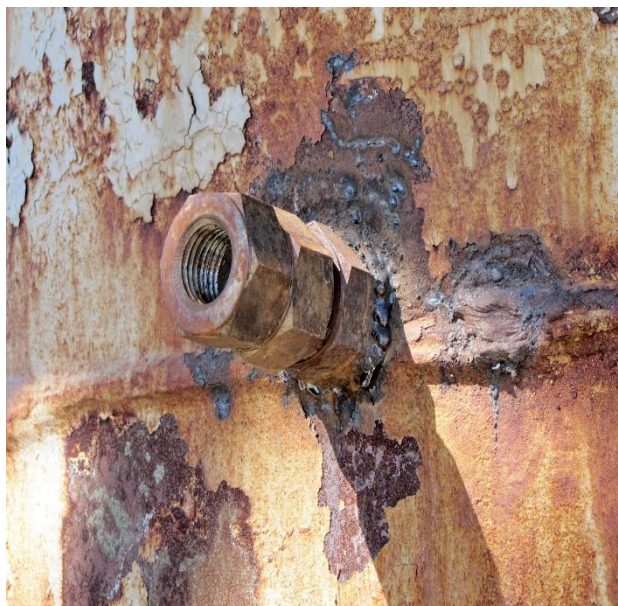
Рис. 3. Тимчасова заглишка на місці прогару у стовбурі димової труби
