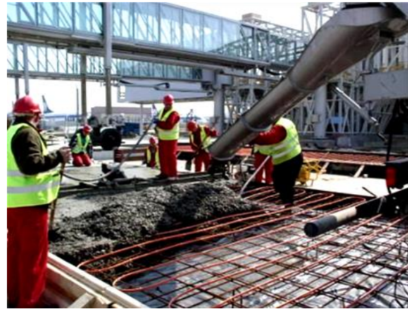
Рис. 5. Виробництво робіт по спорудженню відкритої бетонної площини, обладнаної електричною саморегулюючою кабельною системою захисту від снігу та льоду
